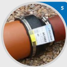
Desserrer les bandes de serrage et glisser le raccord sur le premier tuyau.
